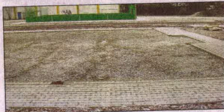
Platz für den zweiten Soccer-Court: Die Umrandung ist schon fertig.
