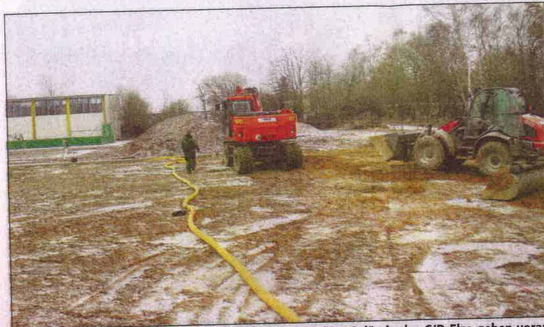
Drainage für das Kleinspielfeld: Die Bauarbeiten auf dem Gelände des CJD Elze gehen voran. Im Sommer soll es im „Sportweltenpark“ bereits rund gehen.
